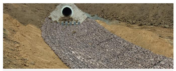
Steinmatratze im Netzschlauch aus PE-Garn
